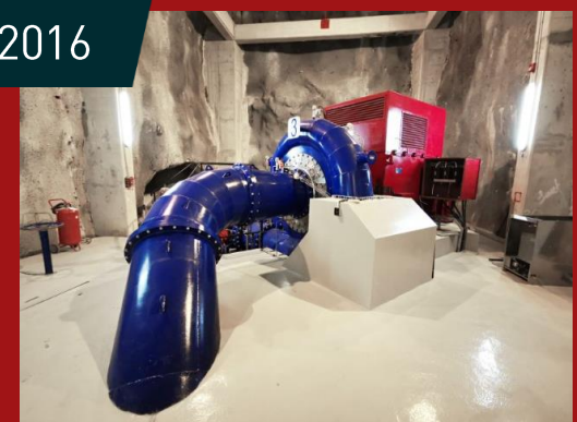
HPP Skhalta, Georgia 3 530 kVA, 6.3 kV, 600 rpm, IM B3, IC 01 Francis Turbine
